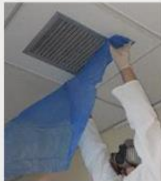
Pose du sac poubelle sur l'aération
